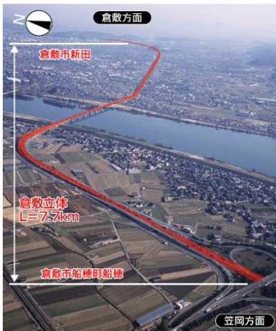
終点側より西方面(倉敷方面)を望む
