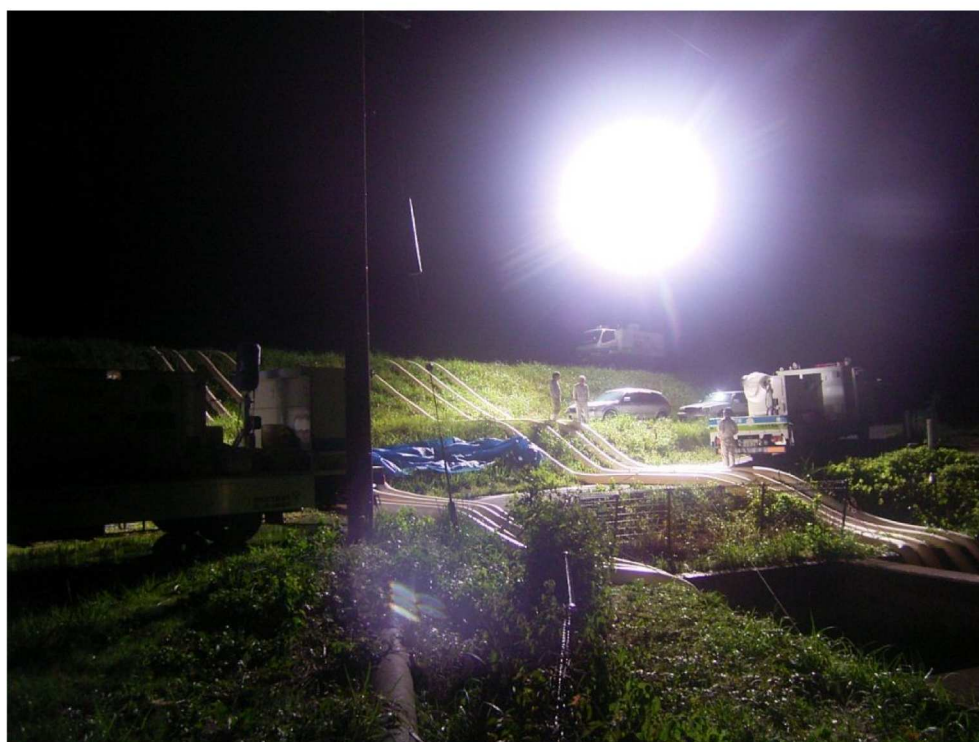
照明車稼働状況 (H25.9.16)
