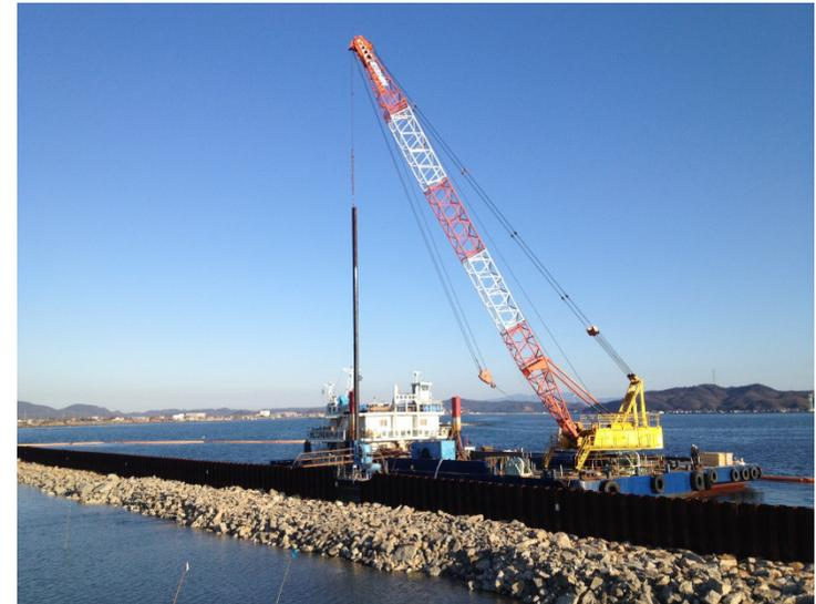
施工状況: クレーン付き台船を使用して仮締切矢板を抜いてます。
