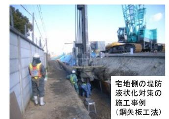
宅地側の堤防液状化対策の施工事例(鋼矢板工法)
