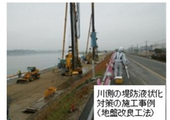
川側の堤防液状化対策の施工事例(地盤改良工法)
