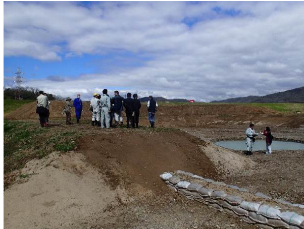
▲協議会メンバーによる現地視察
