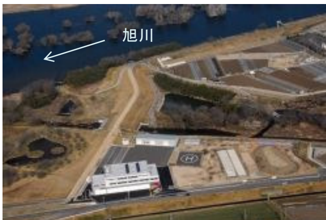
防災ステーション全景
