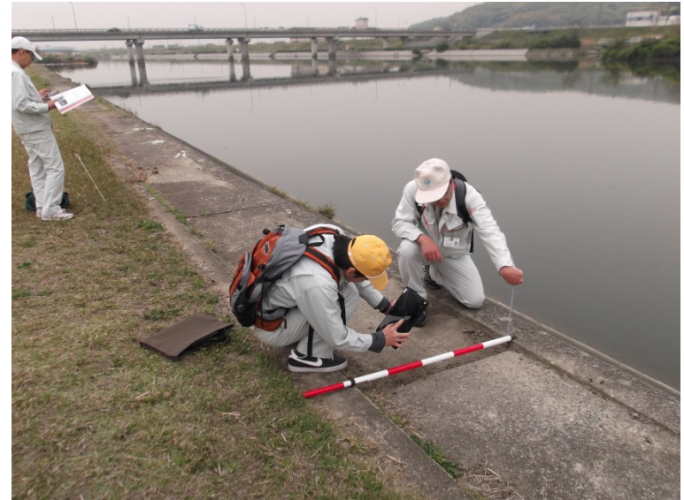
洪水期前の堤防点検の様子
