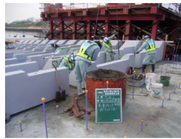
魚道の施工状況
