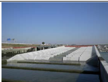
魚道本体の改良完成
