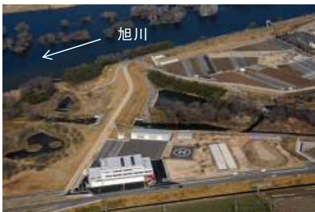
防災ステーション全景
