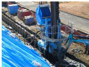
高潮耐震堤防工事の状況
