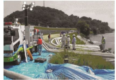
排水ポンプ車操作訓練(高梁川)
