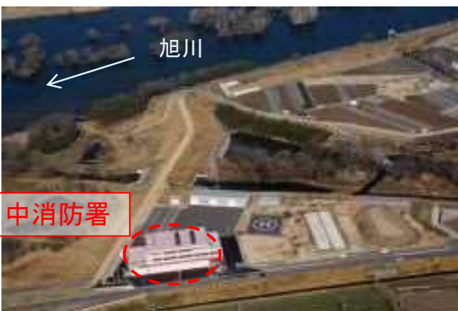
防災ステーション全景
