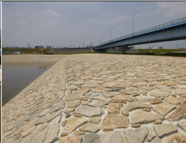
石張り完成状況
