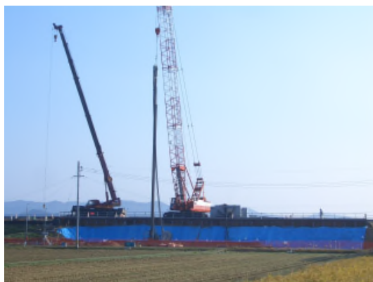
【参考】高潮耐震工事の状況（鋼矢板圧入）
