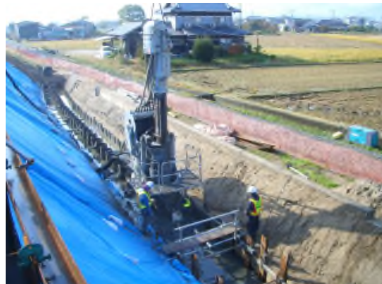
【参考】高潮耐震工事の状況（鋼矢板圧入）
