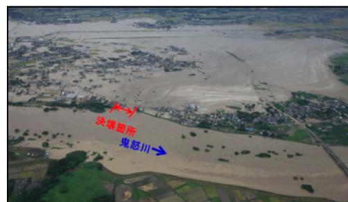
平成27年9月鬼怒川の氾濫による 茨城県常総市の被災状況
