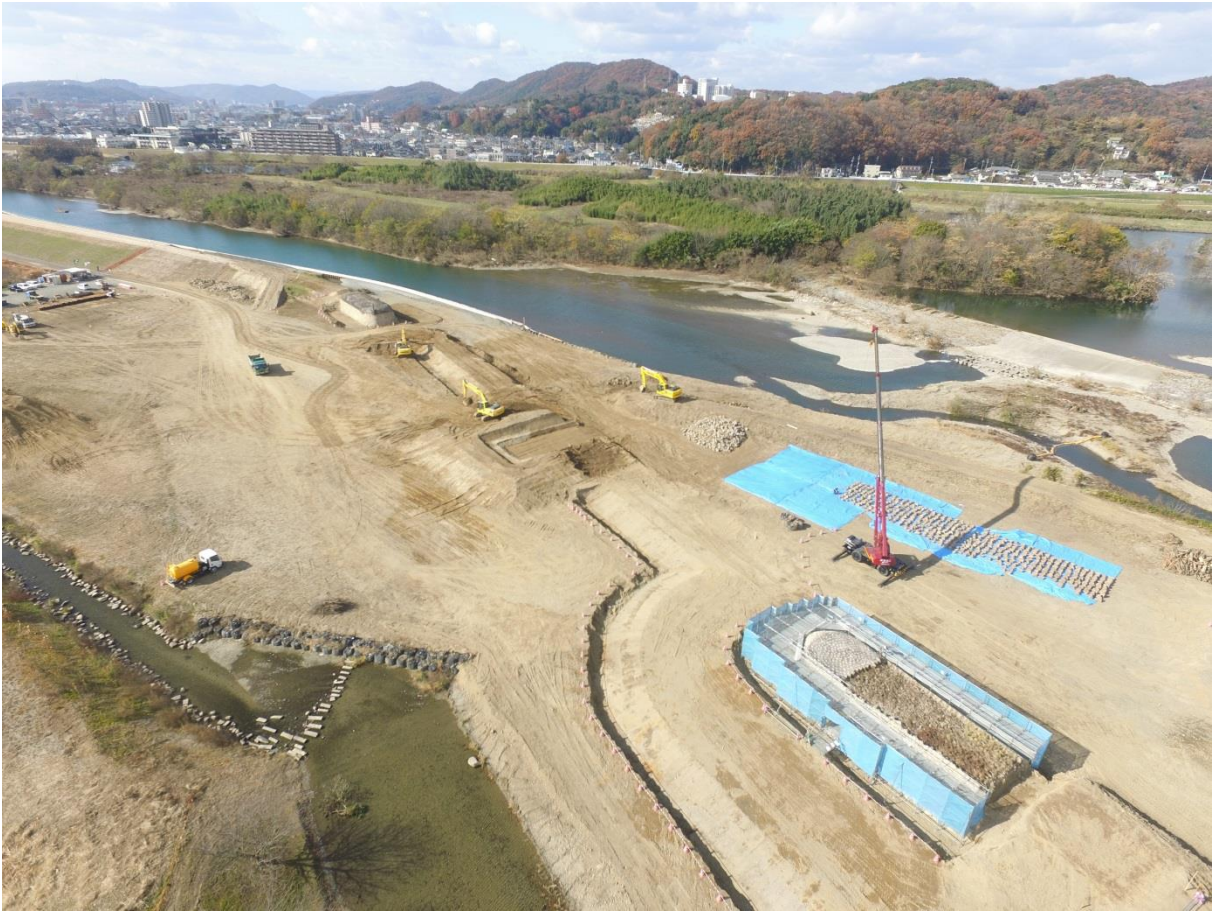
百間川一の荒手改築工事
