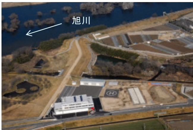
防災ステーション全景
