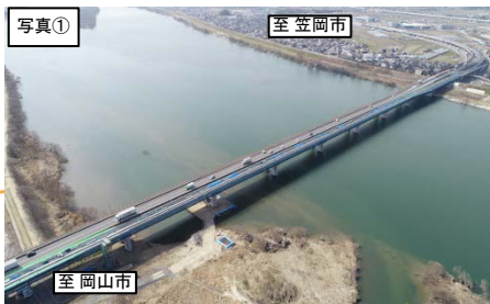
【写真①】高梁川大橋の架橋状況
