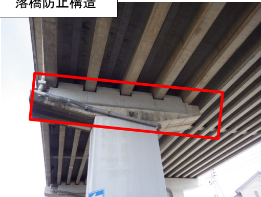
落橋防止構造
