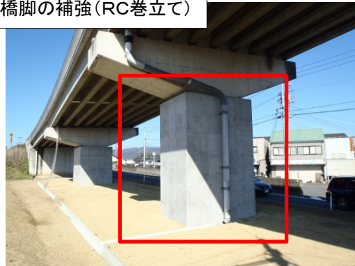
橋脚の補強(RC巻立て)
