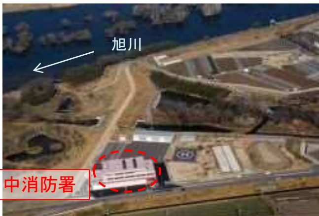
防災ステーション全景
