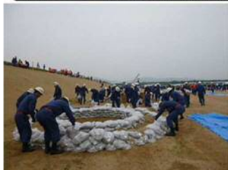
水防団による水防工法訓練
