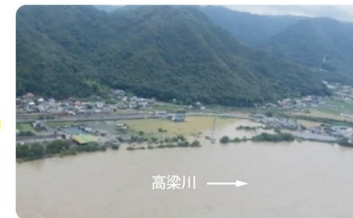
【溢水】 左岸 22k600～23k200 付近
