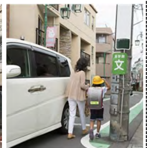
<歩行の支障となる電柱の事例>
