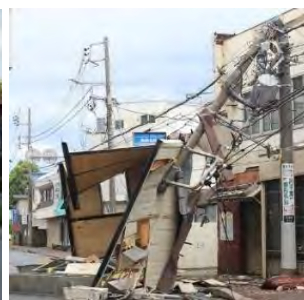
<飛来物による電柱倒壊の事例>
