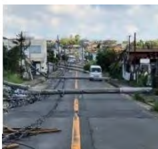
<電柱の倒壊による道路閉塞の事例>
