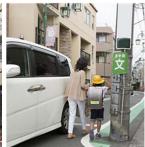
＜歩行の支障となる電柱の事例＞
