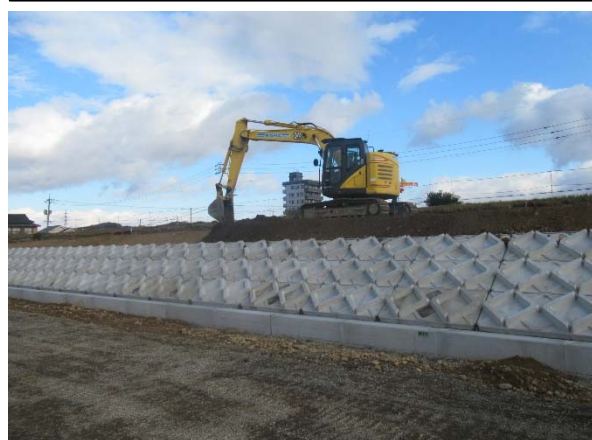
堤防整備の状況
