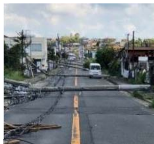
＜電柱の倒壊による道路閉塞の事例＞
