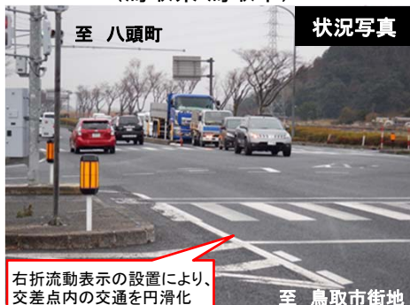
国道29号 古海交差点 (鳥取県 鳥取市)
