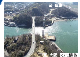
【写真②】神島地区の施工状況
