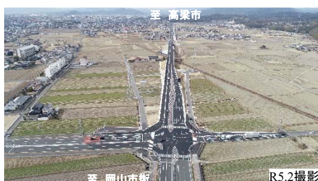
てんばら 【写真①】天原地区の施工状況
