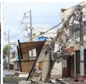
＜飛来物による電柱倒壊の事例＞
