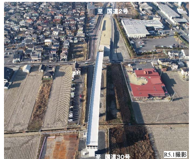
【写真①】大福地区の施工状況
