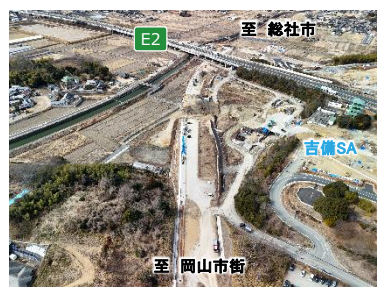
【写真②】今岡地区の施工状況（R7.2撮影）
