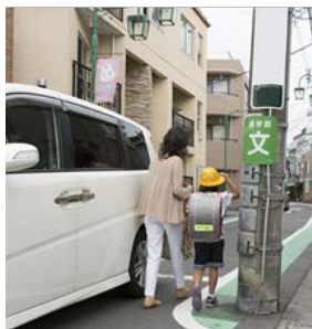
＜歩行の支障となる電柱の事例＞
