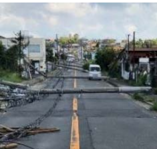
＜電柱の倒壊による道路閉塞の事例＞
