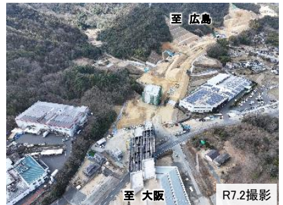
【写真①】里庄IC付近の施工状況
