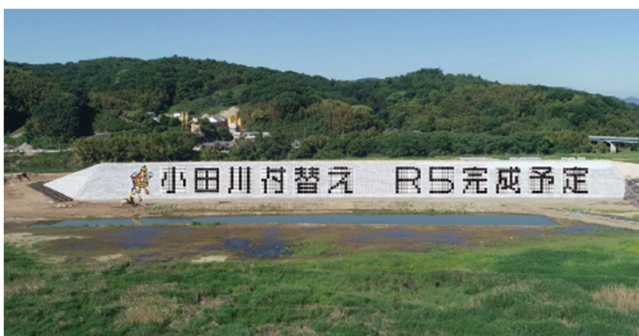
上流締切堤防護岸 完成イメージ
