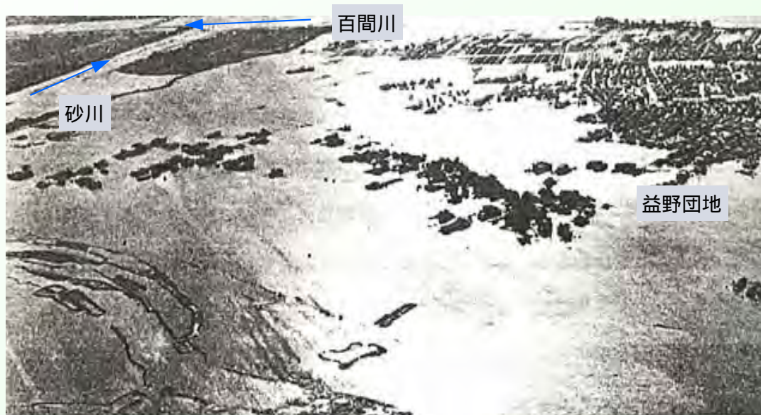
岡山市益野団地付近の内水による浸水状況
