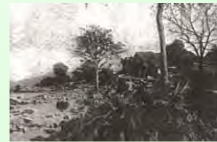
③ 岡山市出石町の堤防破損箇所
