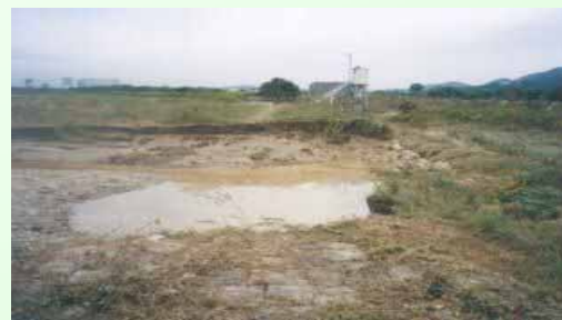
一の荒手被災状況
