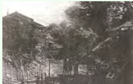
② 岡山市石関町の堤防破損箇所
