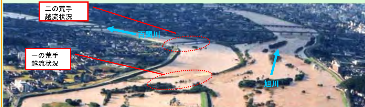
百間川分流部周辺の出水状況
