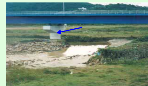
二の荒手被災状況
