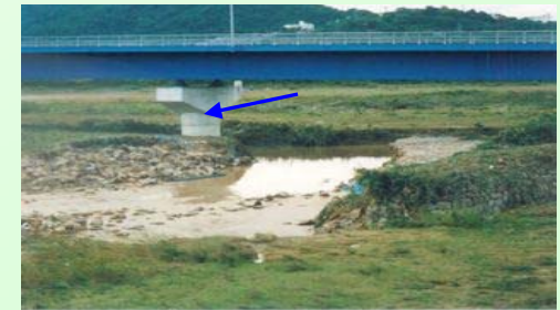
二の荒手被災状況
