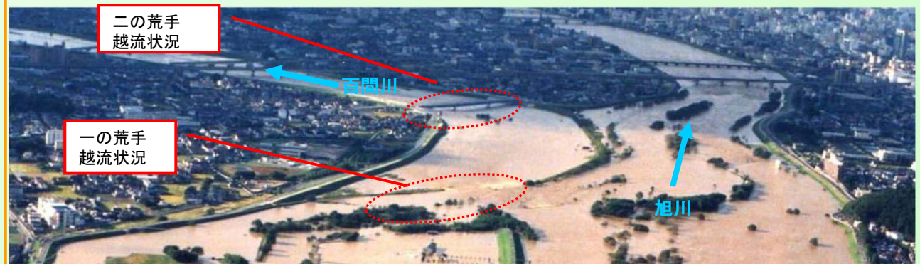
百間川分流部周辺の出水状況
