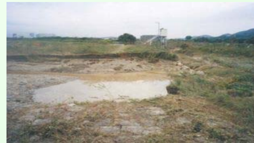
一の荒手被災状況
