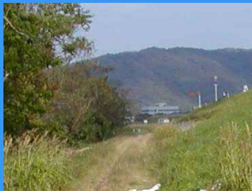
..... 未整備区間の様子 (旭川:岡山市)
