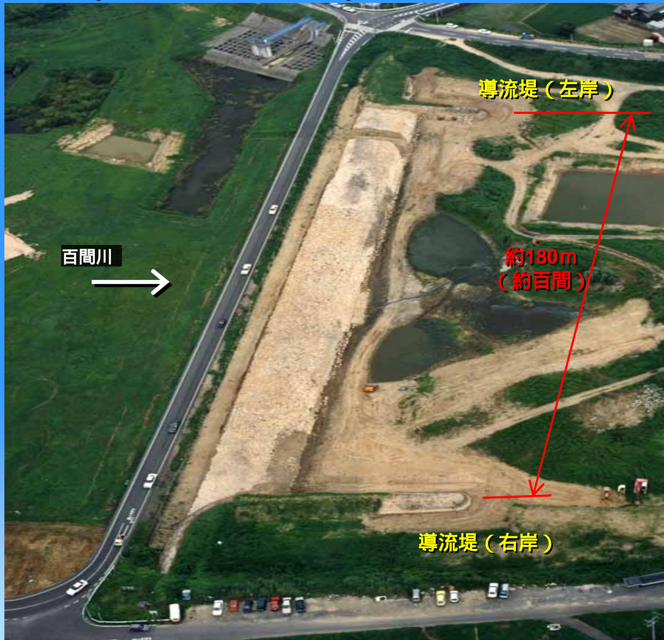
全 景（中島竹田橋整備前の様子）
