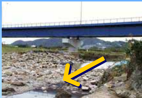
「二の荒手」の破壊状況
