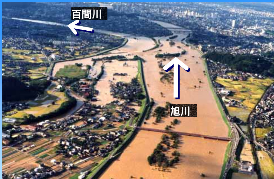
平成10年洪水の状況(一の荒手)
