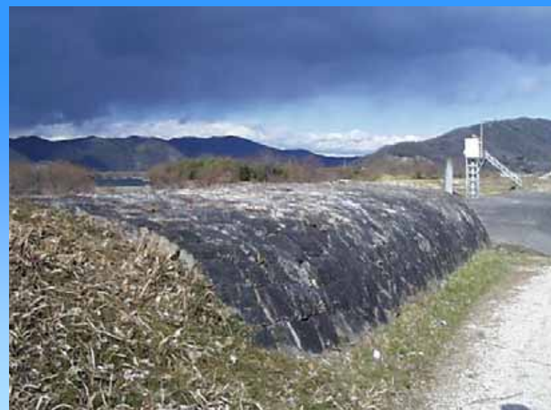
下流側の「亀の甲」
