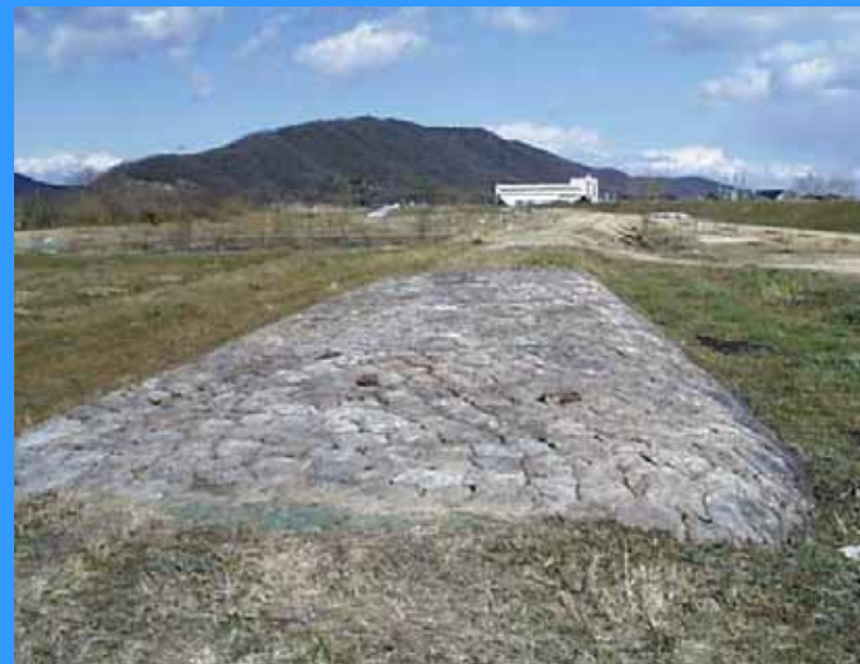
上流側の「亀の甲」
