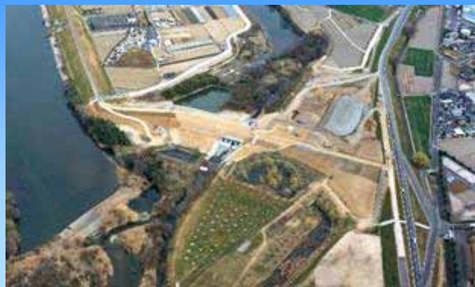
・防災拠点、ホタル池、明星堰周辺の様子
