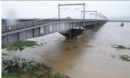
例：高水敷の冠水
