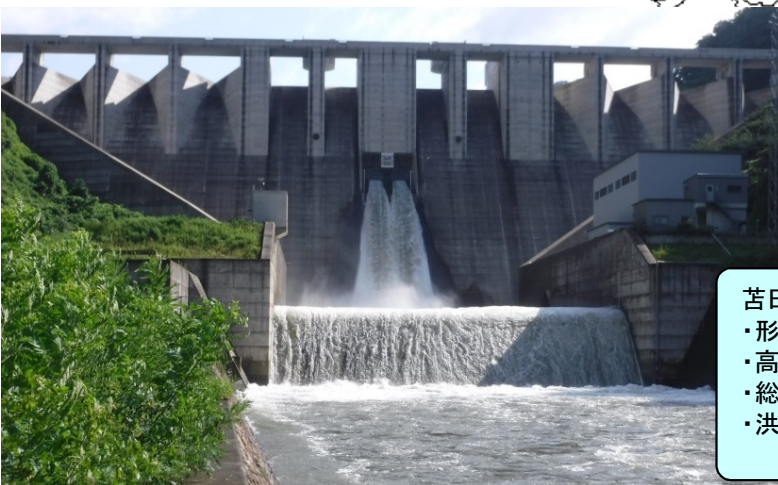
苦田ダムの放流状況
