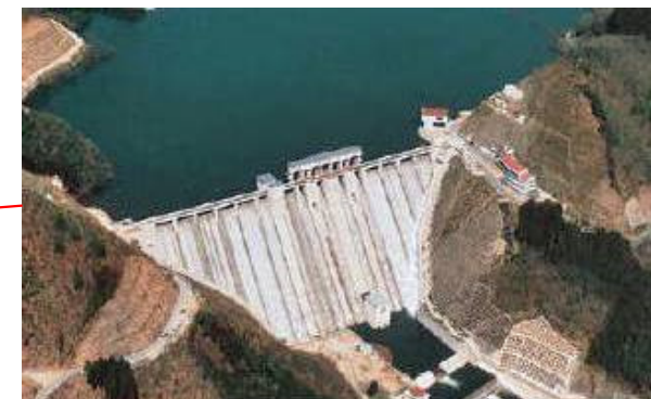
千屋ダム(岡山県管理)
