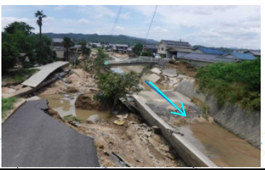
【堤防の決壊】左岸L=約200m 右岸L=約300m 末政川左右岸0k700付近(県)
