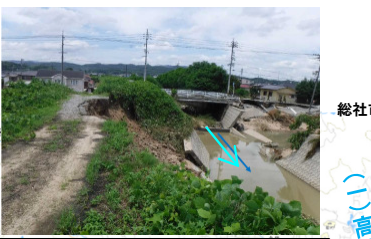
【堤防の決壊】L=約20m 末政川左岸0k400付近(県)
