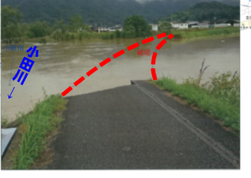
【堤防の決壊】L=約50m 小田川左岸6k400付近
