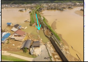
【堤防の決壊】 左岸L=約20m(高馬川左岸0k付近) 右岸L=約100m(高馬川右岸0k100付近)
