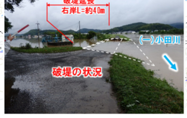
【堤防の決壊】L=約40m 小田川左岸15k900付近(県)
