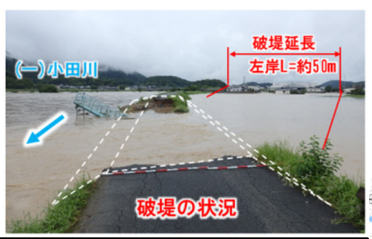
【堤防の決壊】L=約50m 小田川左岸14k900付近(県)
