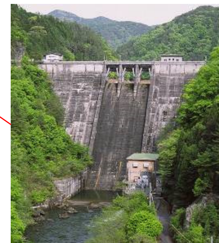
小阪部川ダム (高梁川用水土地改良区管理)
