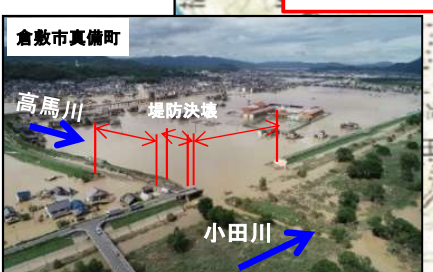
平成30年7月梅雨前線 建物浸水被害約4,600棟 (住家・非住家・床上浸水・床下浸水等内訳は確認中)※平成30年7月現在
