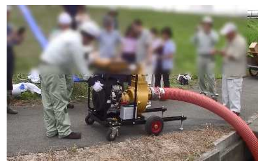
可搬式ポンプ試運転実施状況
