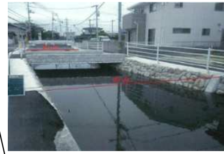
倉安川改修工事完了箇所
