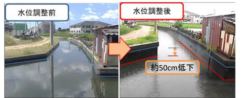
用水路の事前の水位調整状況
