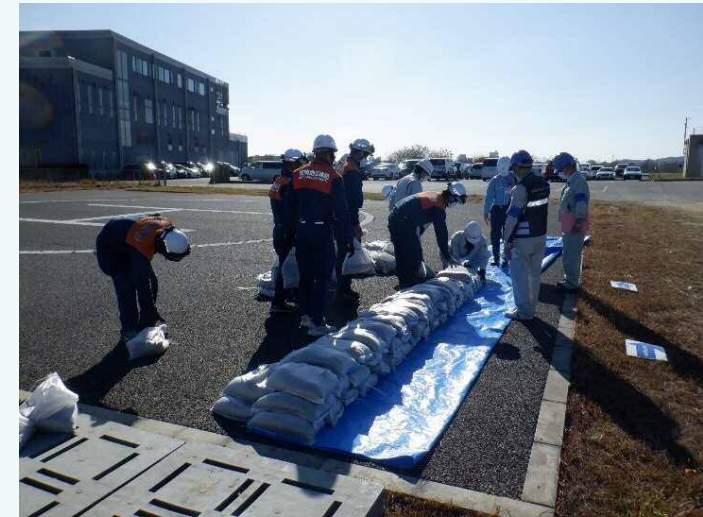
改良積み土のう工法
