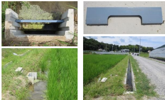
堰板等設置風景
