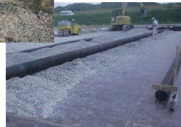
採石貯留槽 設置状況
