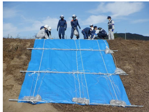
シート張り工法
