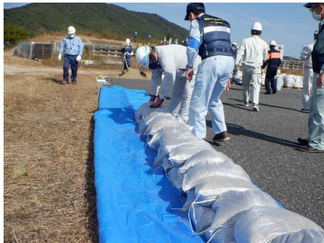
改良積み土のう工法
