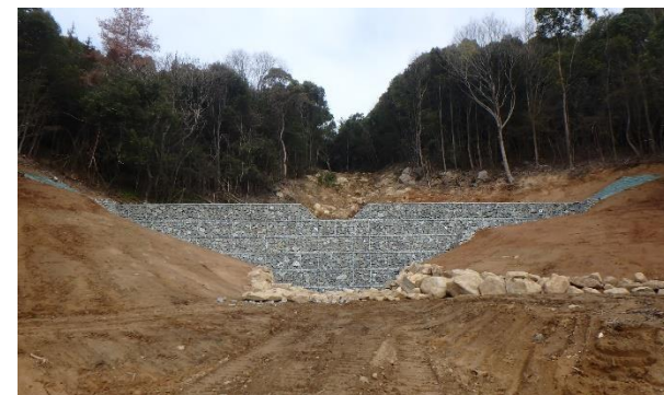
H31加賀山災害復旧工事(溪間工1基)
