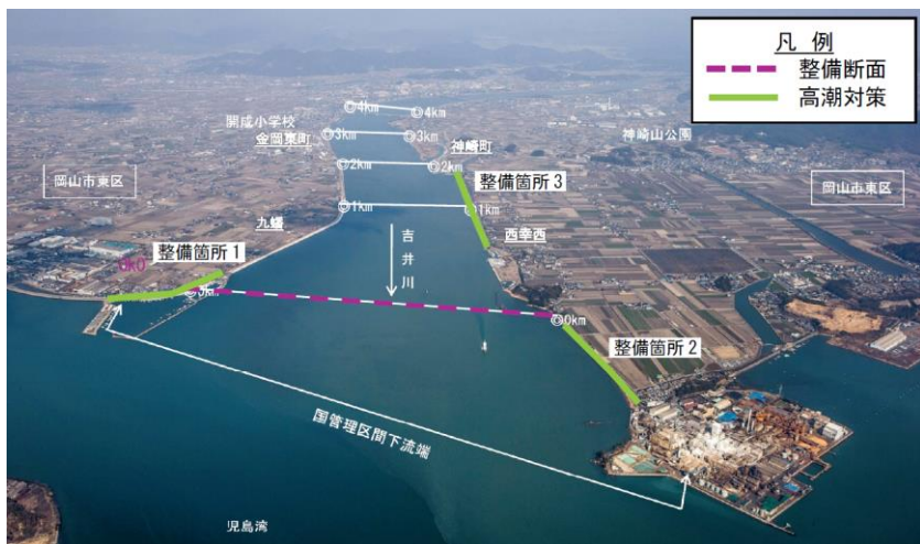
高潮対策区間(九蟠・西幸西地区)
