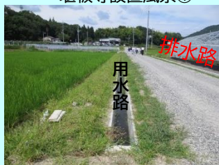
堰板等設置風景②
