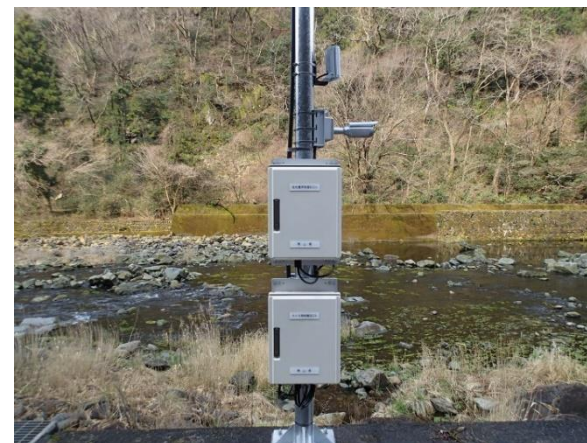
簡易型河川監視カメラ
