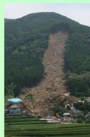
被災直後の様子 (平成21年7月撮影)
