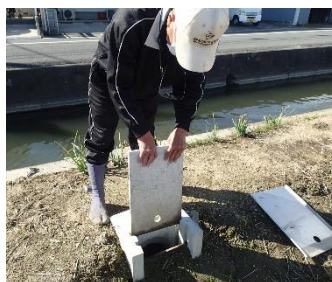
堰板等設置状況(ほ場)
