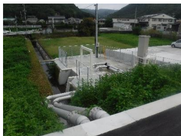
西町排水ポンプ場
