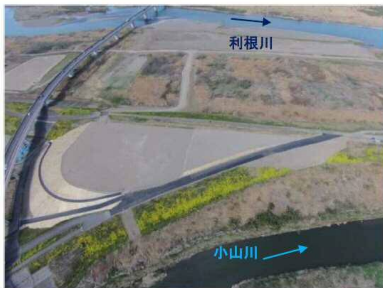
下高島地区(埼玉県深谷市)
