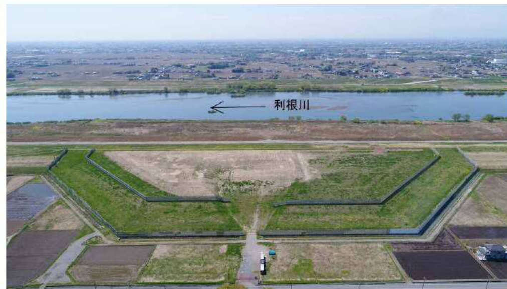
栄地区広域避難地(埼玉県加須市)
