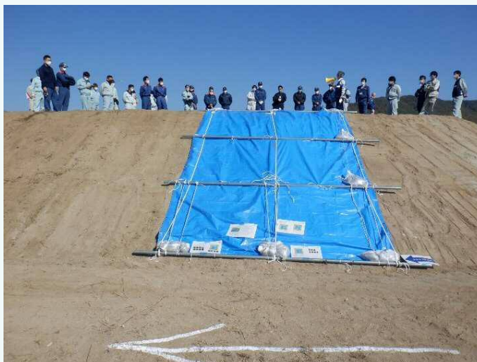
シート張り工法
