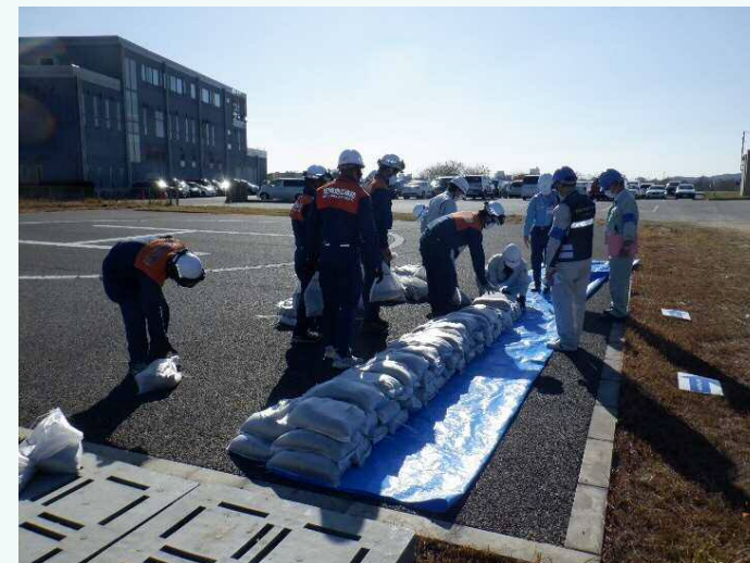
改良積み土のう工法
