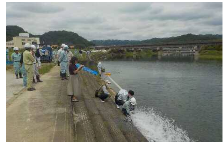
▲建設業者との合同訓練(木之子町内小田川河川敷)
