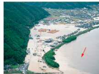
赤松市吉井川氾濫田(平成10年洪水)
