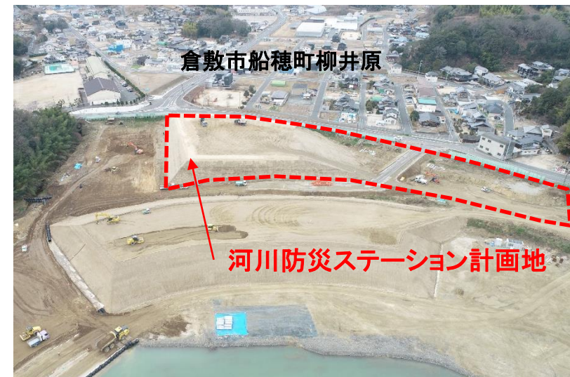
河川防災ステーション基盤整備の様子
