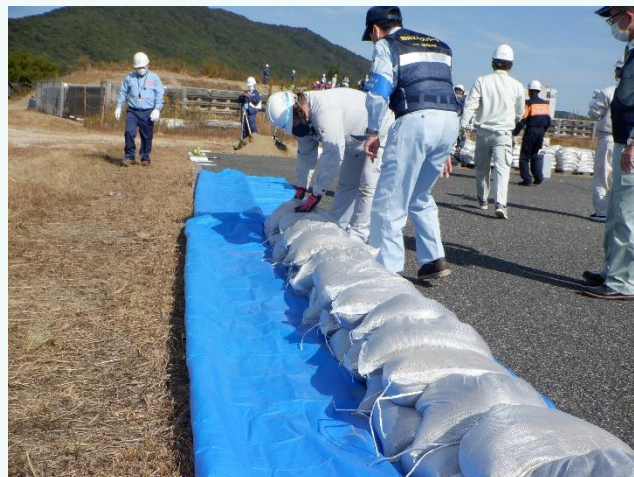
改良積み土のう工法
