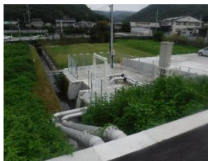
西町排水ポンプ場
