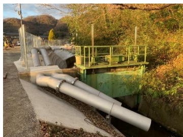
伊賀寺排水ポンプ場
