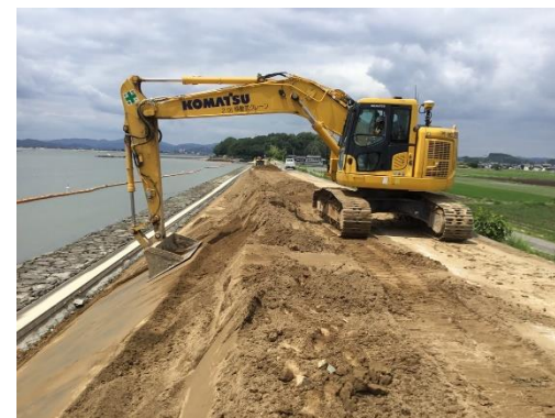
築堤の様子 (西幸西地区:左岸-0.7km~0km)
