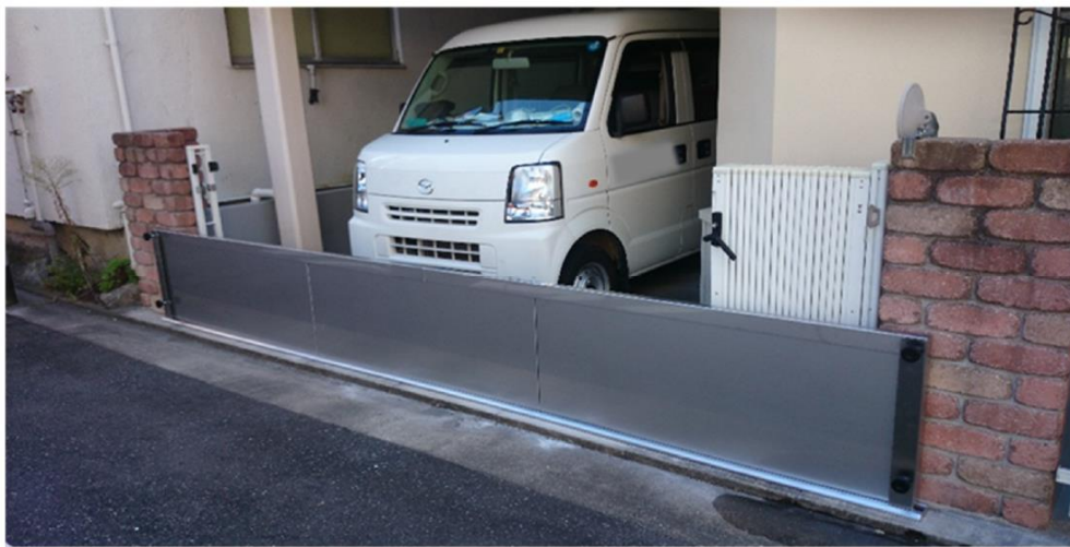
【止水板の設置例】
