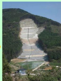
山腹工施工直後の様子 (平成22年10月撮影)
