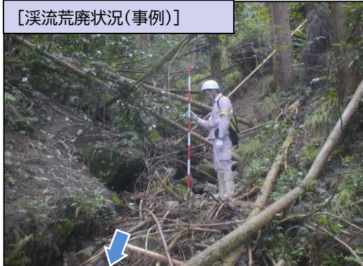
[被害事例]新見市局地豪雨被害(令和元年9月)
