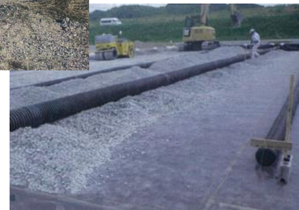
採石貯留槽 設置状況
