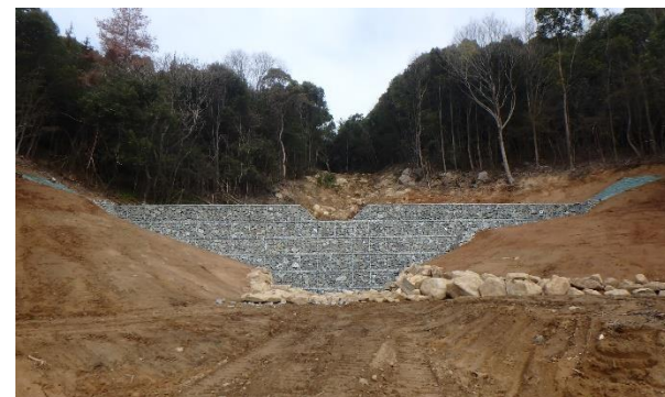
H31加賀山災害復旧工事(溪間工1基)
