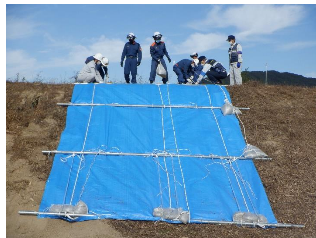
シート張り工法
