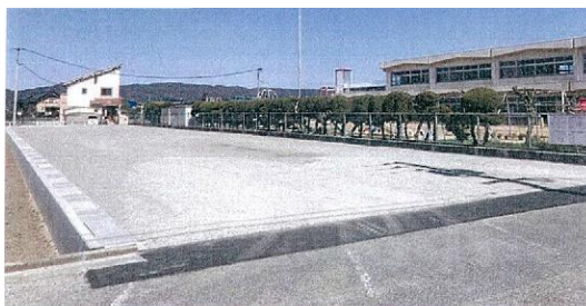
採石貯留槽 設置状況
