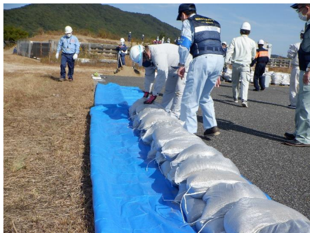
改良積み土のう工法
