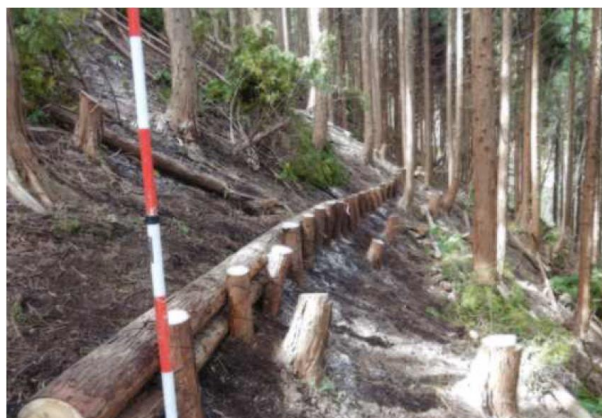
丸太筋工の実施状況
