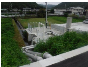
西町排水ポンプ場
