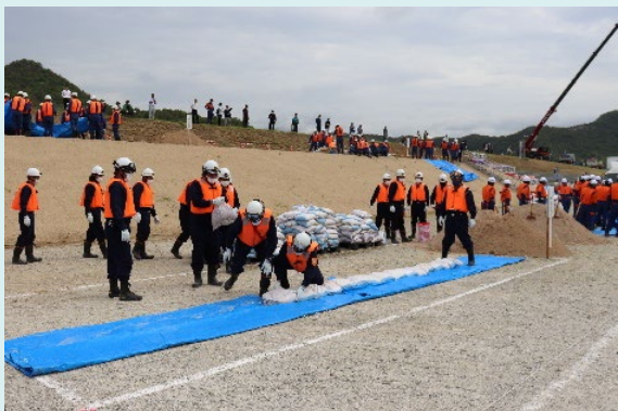
水防団で協力して 水防工法実施
