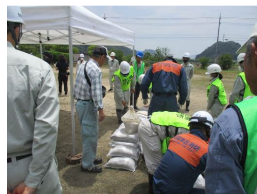
▲住家浸水防止に資する土のう作成・積工法
