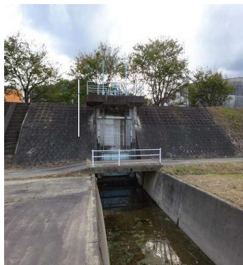
施工前(第2ポンプゲート)
