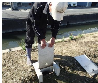
堰板等設置状況(ほ場)
