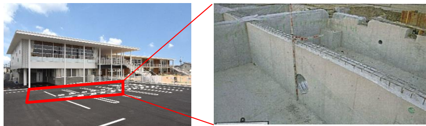
ピット貯留槽 設置状況
