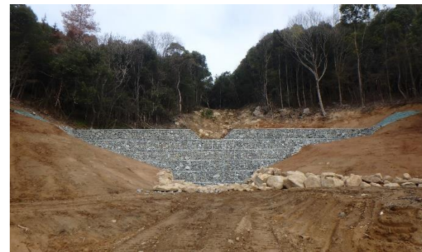
H31加賀山災害復旧工事(溪間工1基)
