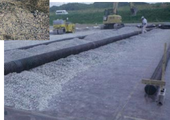
採石貯留槽 設置状況
