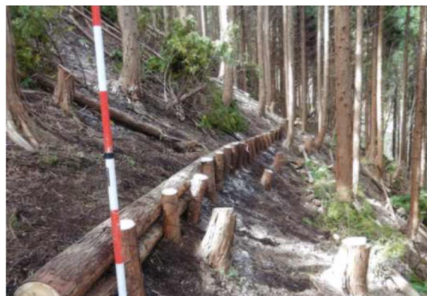
丸太筋工の完了状況
