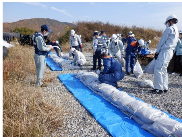
改良積み土のう工法
