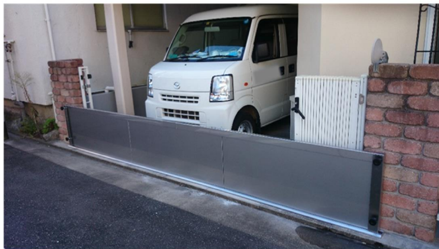
【止水板の設置例】
