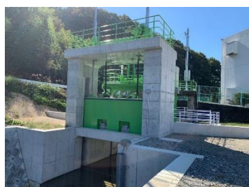
南部排水ポンプ場 (R4新設)
