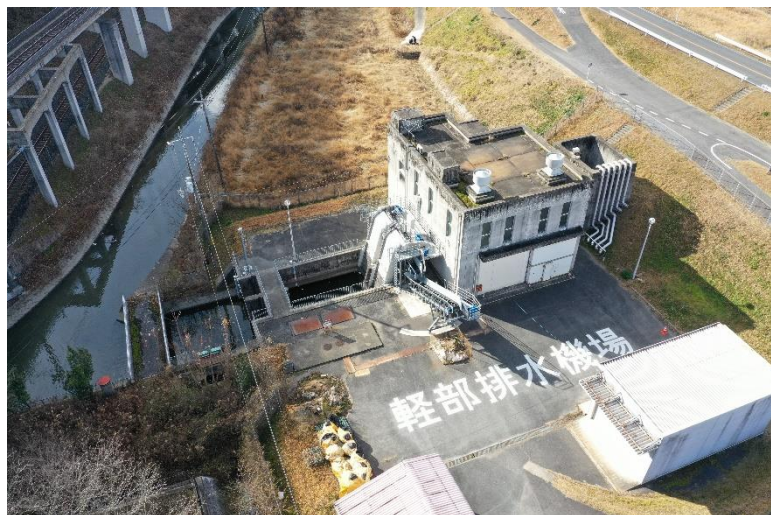
軽部排水機場の運転水位の見直し
