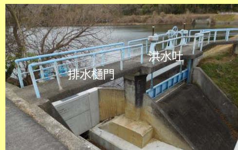
岩田大池の洪水吐と排水樋門(下流側から)
