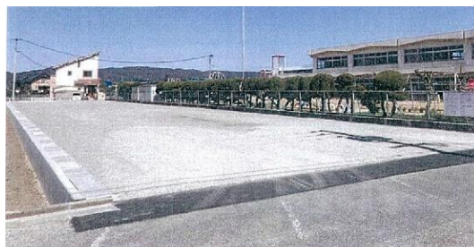
採石貯留槽 設置状況
