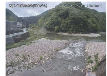
河本ダム直下流画像
