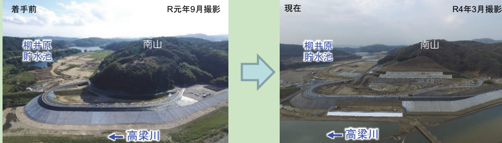
小田川合流点付替え事業（南山掘削）の状況
