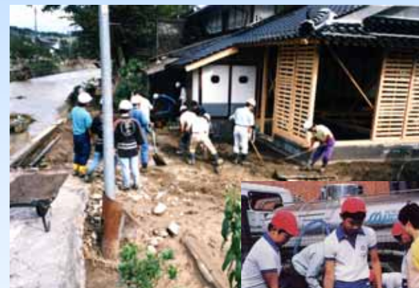
H10.10.18 落合町 応急復旧状況
